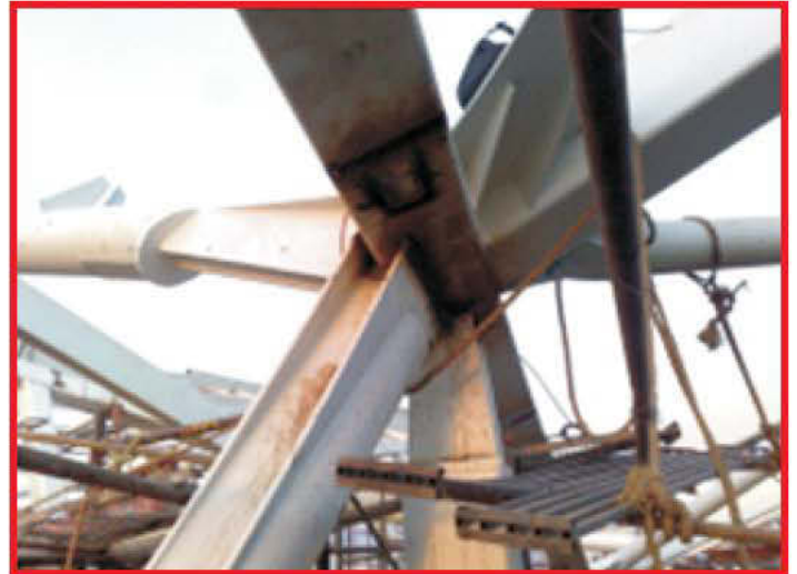
Fig - 17 (d) Actual view
