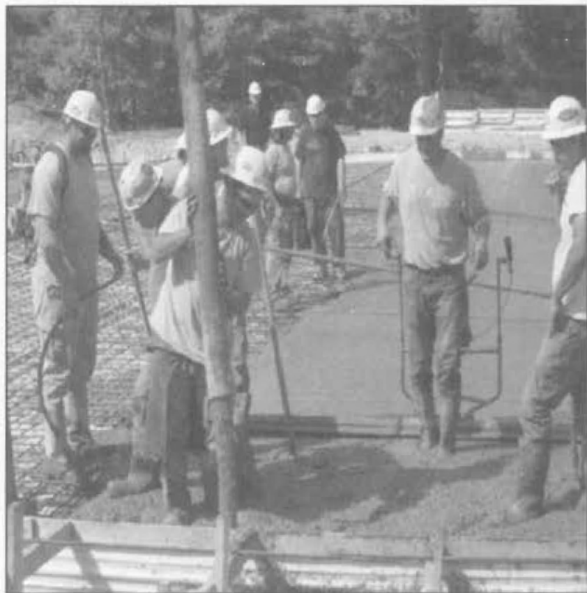
Figure 6: Floor Concrete Pour
